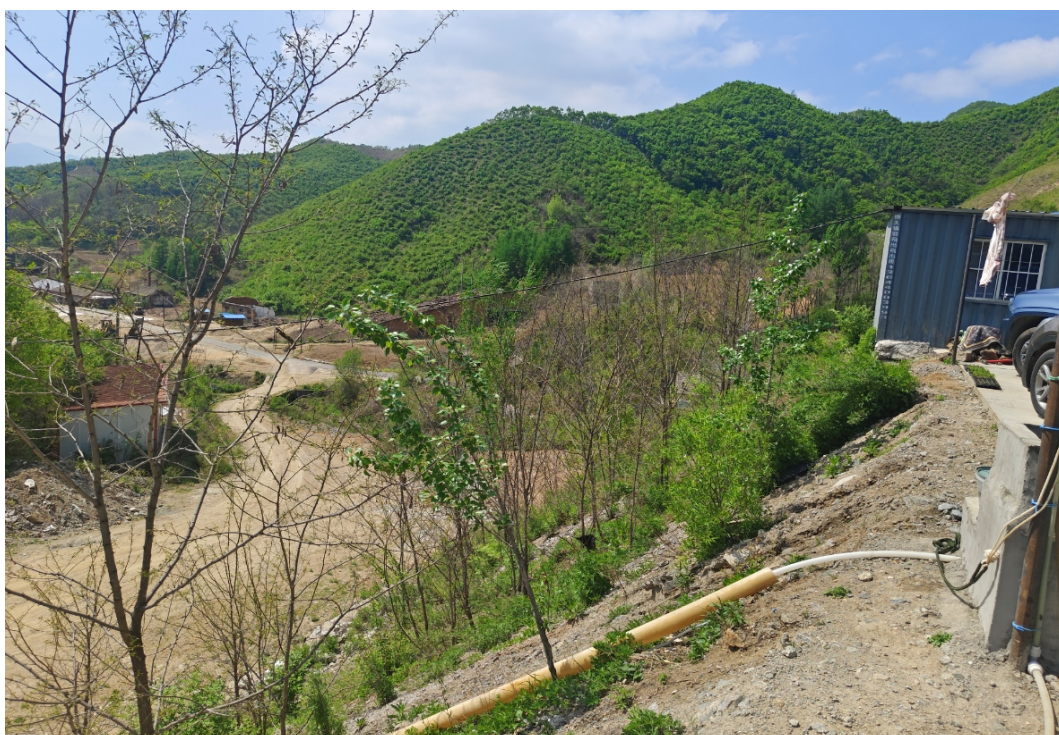
照片 0-1 边坡 1 治理后照片（2021 年治理）
