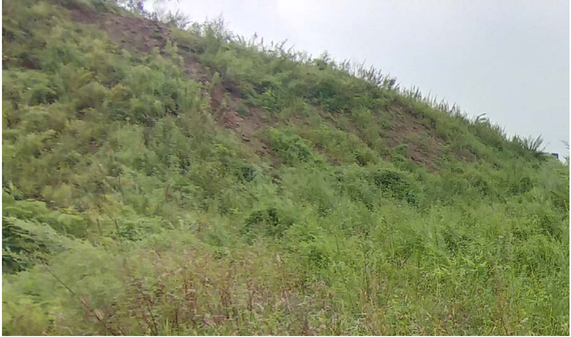
照片 4-1 客土地点照片（远景）
