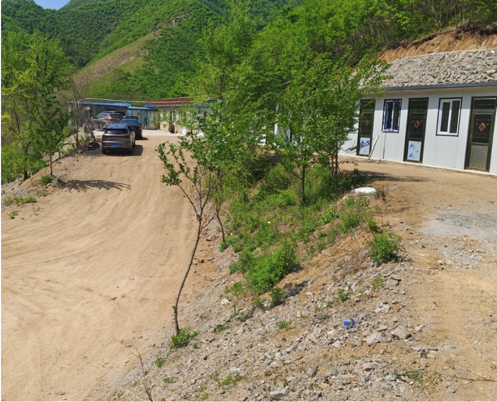
照片 0-2 边坡 1 治理后照片（2021 年治理）
