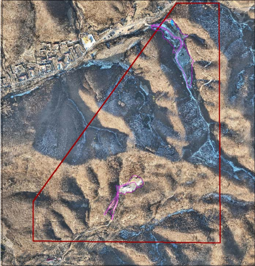
图 3-3 矿山损坏现状航拍图
