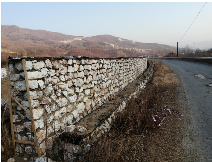
照片 2-9 挡土墙效果照片
