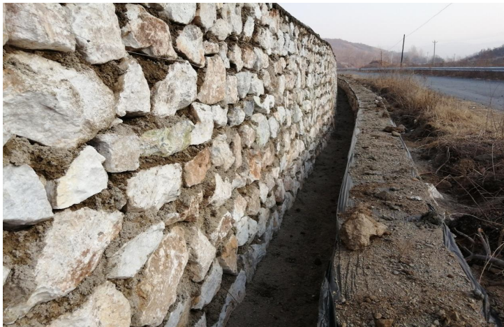
照片 2-8 排水沟、挡土墙效果
