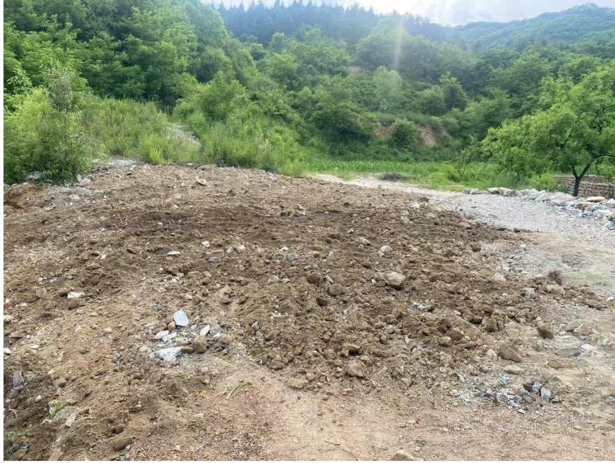
图0-3 覆土现场照片
