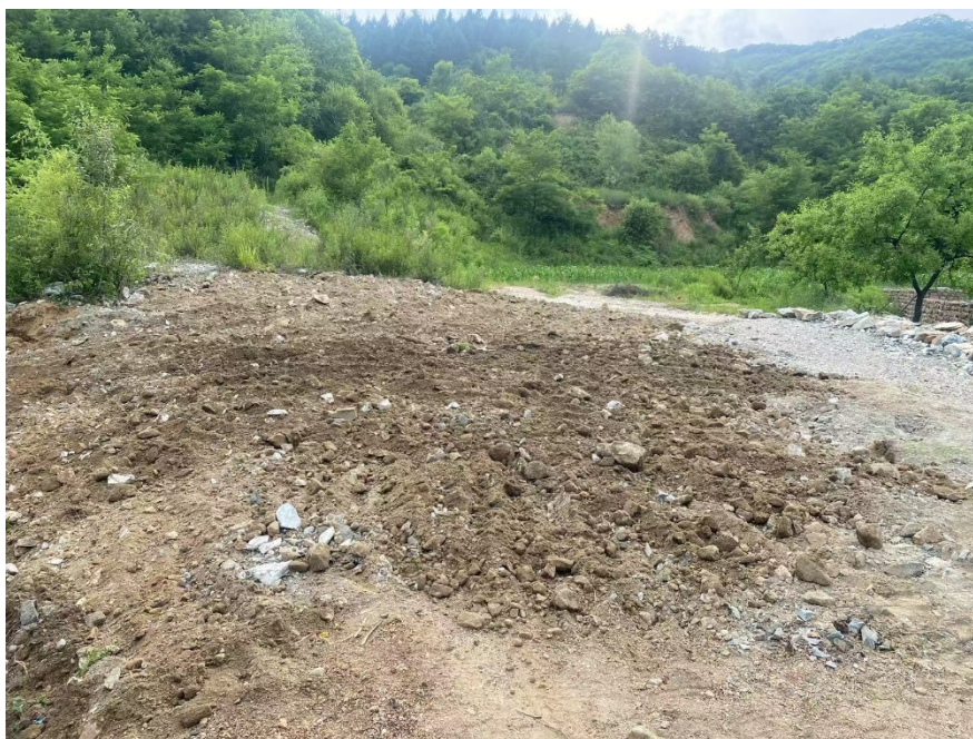
图2-9 覆土现场照片
