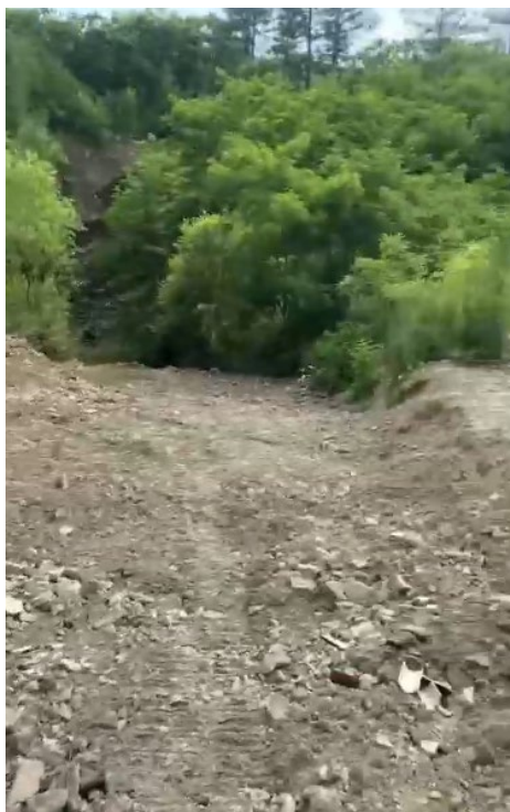
图2-8 覆土现场照片
