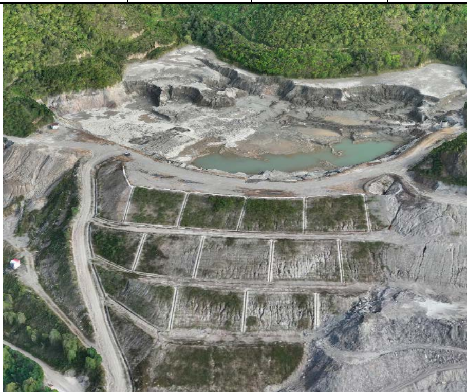
照片 3-6 尾矿库和尾矿坝
