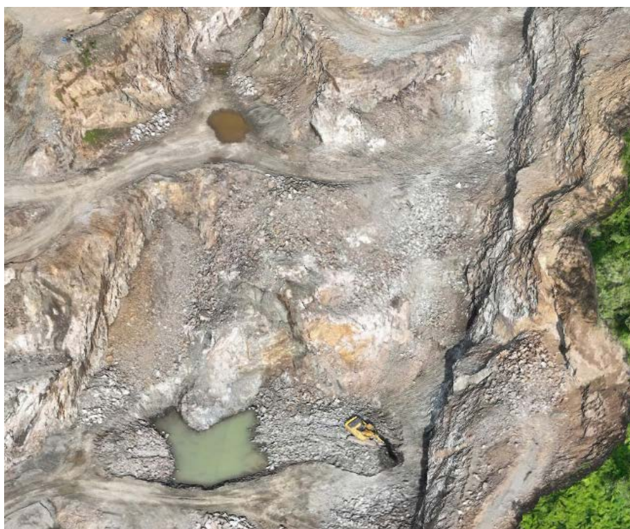
照片 3-1 崩塌地质灾害隐患点
