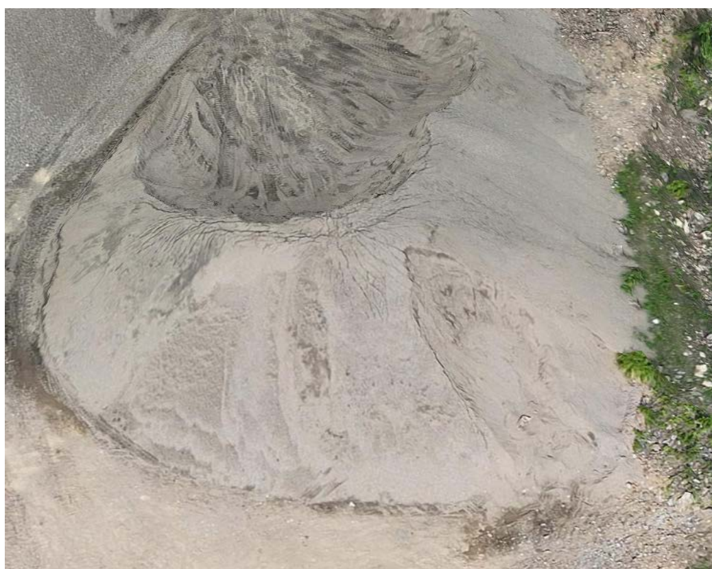
照片 3-6 矿区内排岩场边坡、平台
