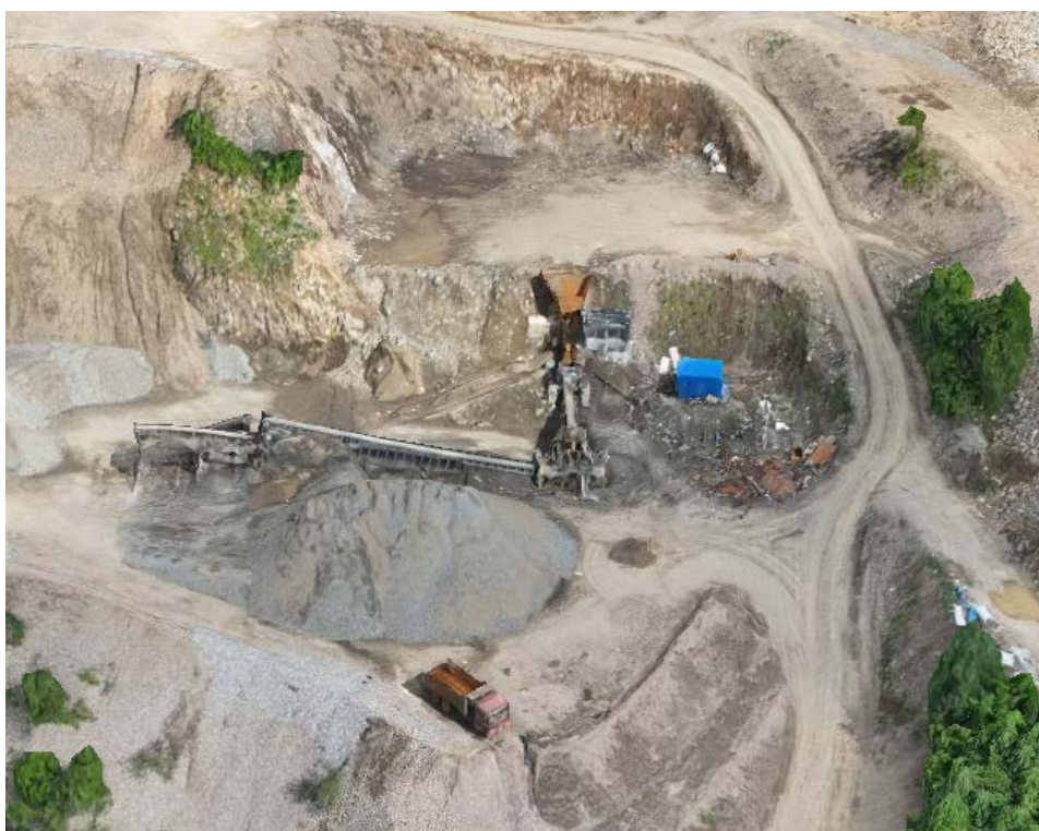
照片 3-9 一采区工业场地
