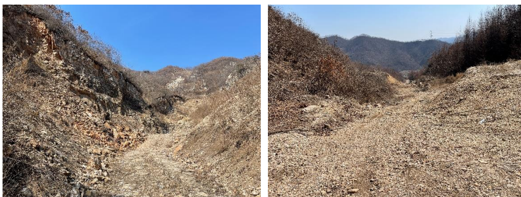
图 3-2 已建运输道路损毁土地情况
