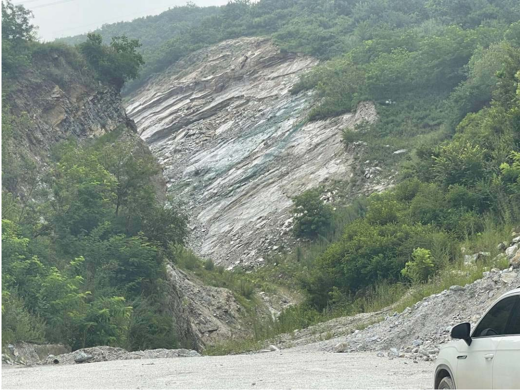
照片 3-19 露天采坑 2
