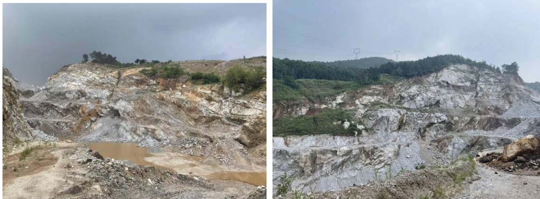
照片 3-18 露天采坑 1
