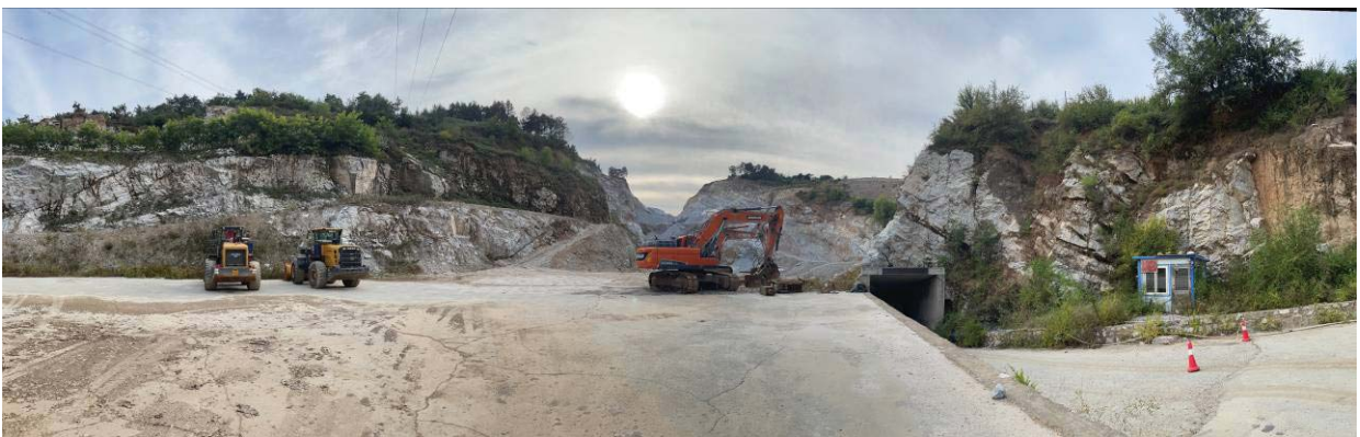
照片 3-1 工业场地和露天采坑远景
