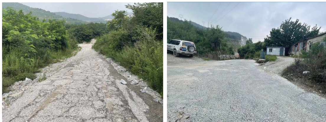
照片 3-22 运输道路 2 和运输道路 3
