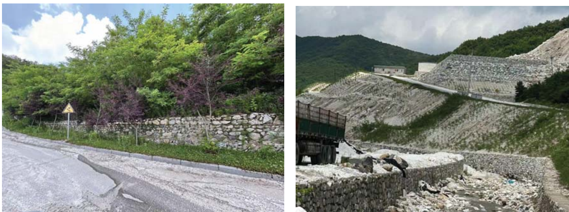
四采区排岩场平台和边坡、路树、播撒草籽照片
