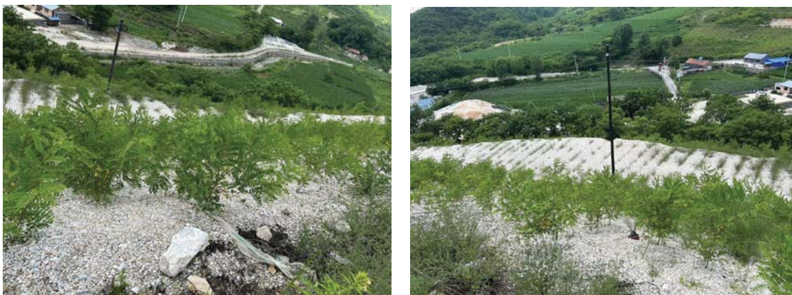
四采区排岩场平台和边坡照片
