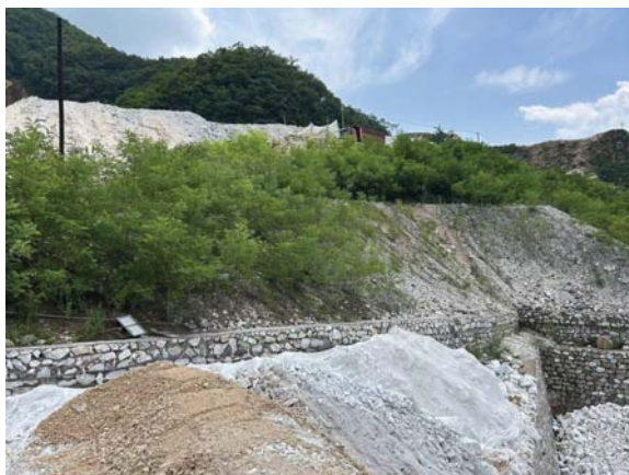
二采区排岩场边坡和平台治理及挡土墙照片
