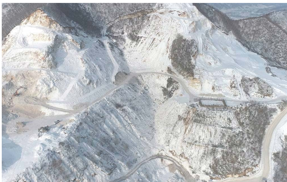
图片 3-5 已建废石场损毁土地现状 2
