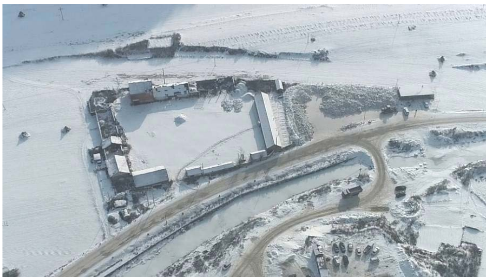
图片 3-6 已建工业场地损毁土地现状
