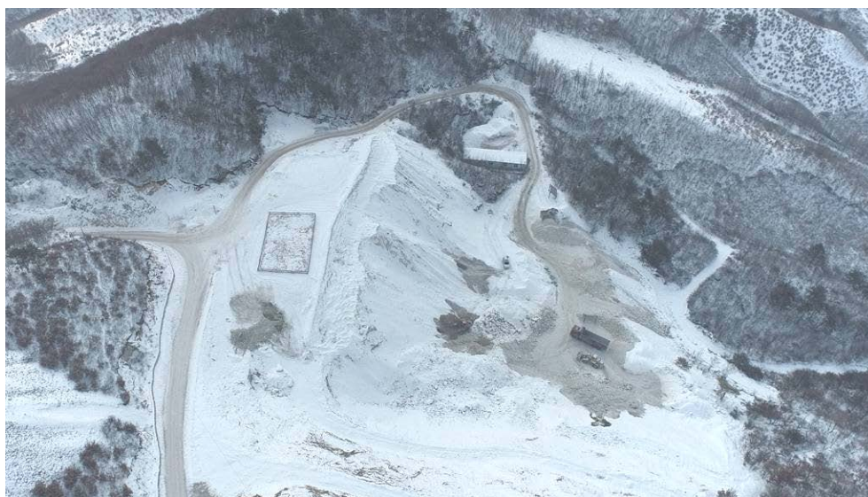
图片 3-4 已建废石场损毁土地现状 1
