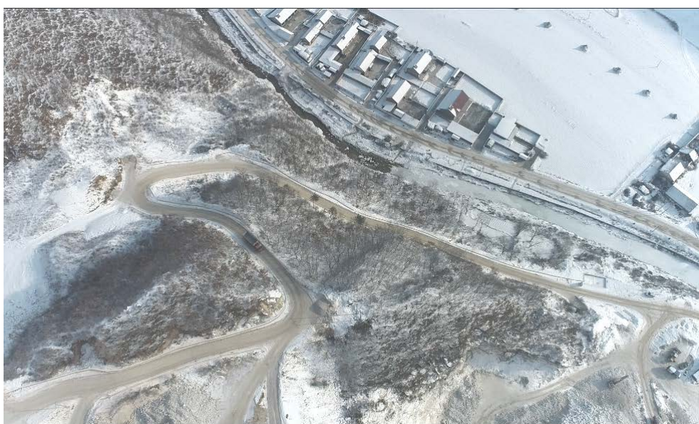
图片 3-7 已建运输道路损毁土地现状
