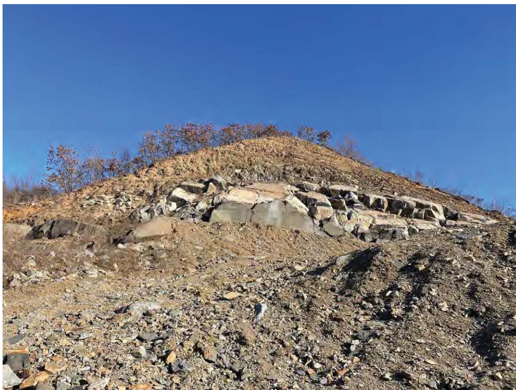
照片 3-1 崩塌地质灾害点
