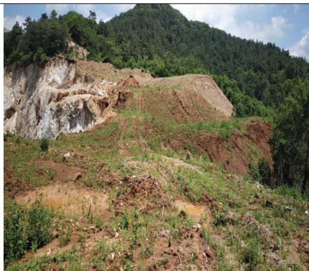
图 2-8 已治理废石场 2
