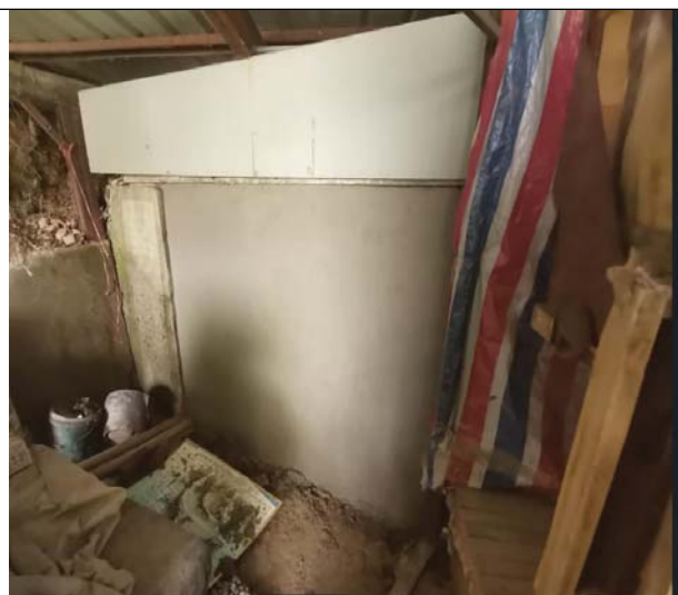
图 0-2 井口浆砌封堵
