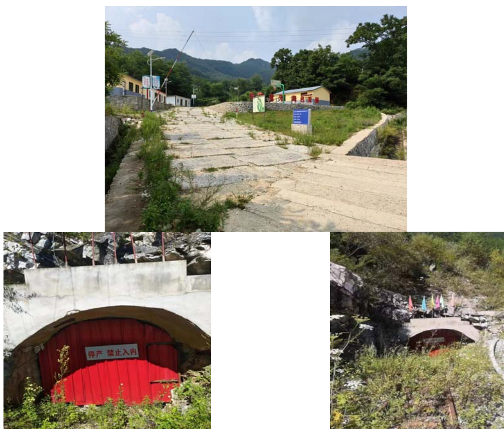
矿山现场情况
