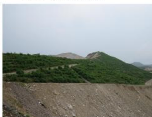
照片 8 治理区削坡平整照片
