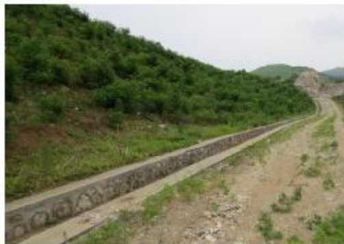
照片 12 治理区横向排水沟照片
