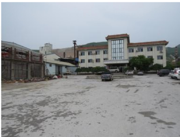
照片 3-5 现状厂房区照片
