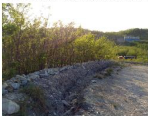
照片 2-8 临矿恢复治理照片
