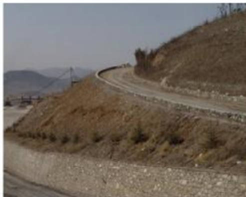
照片 2 边坡全面覆土照片
