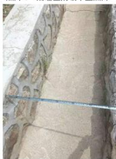
照片 10 排水沟断面尺寸照片
