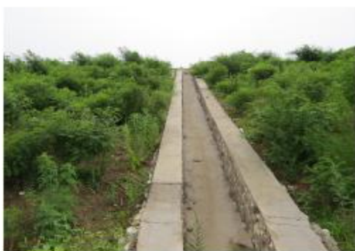
照片 11 治理区竖向排水沟照片
