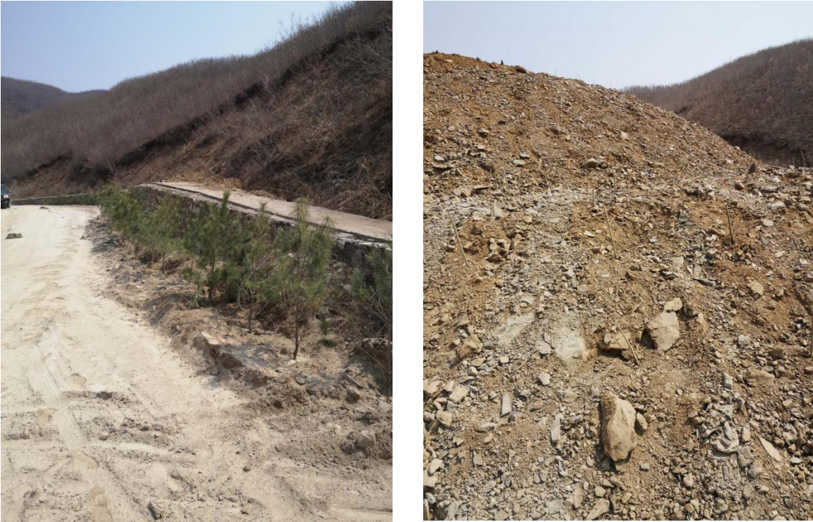
图 2-6 本溪德金矿业有限公司岫岩县贾家堡子萤石矿治理情况
