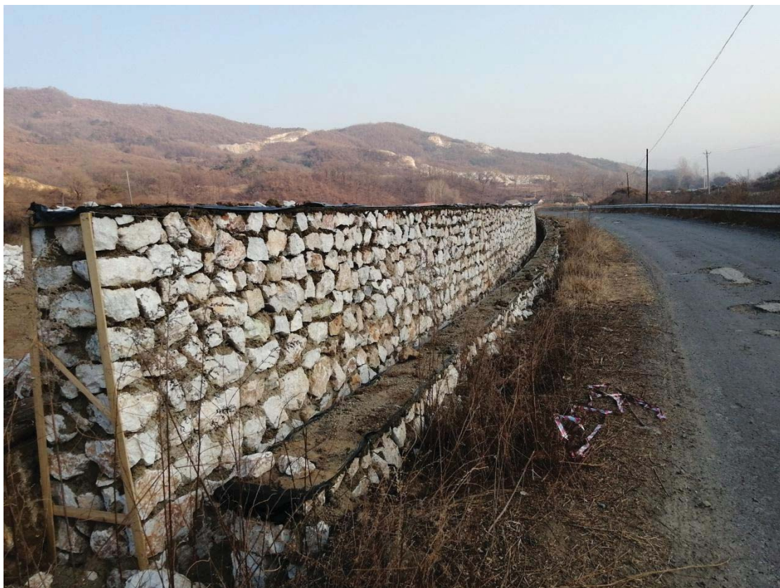
照片 2-9 挡土墙效果照片
