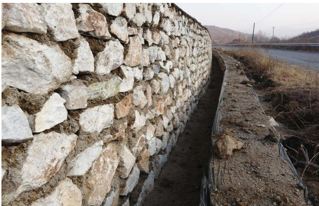
照片 2-7 排水沟、挡土墙效果
