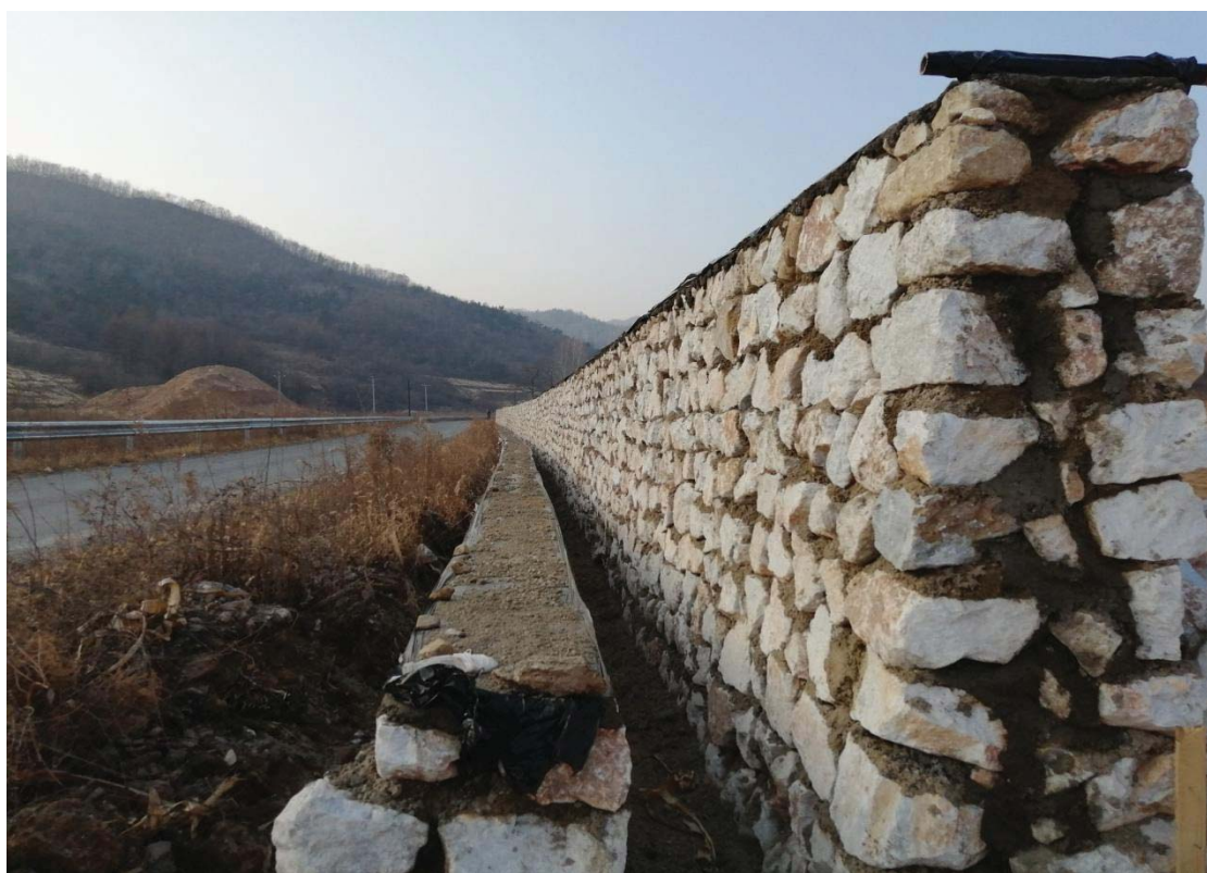
照片 2-10 排水沟、挡土墙效果
