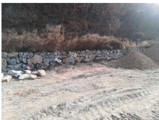
图 1-4 平整及挡土墙
