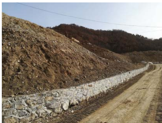
图 1-7 边坡绿化及挡土墙
