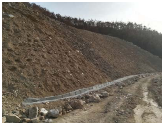
图 1-3 平整、边坡绿化、排水沟
