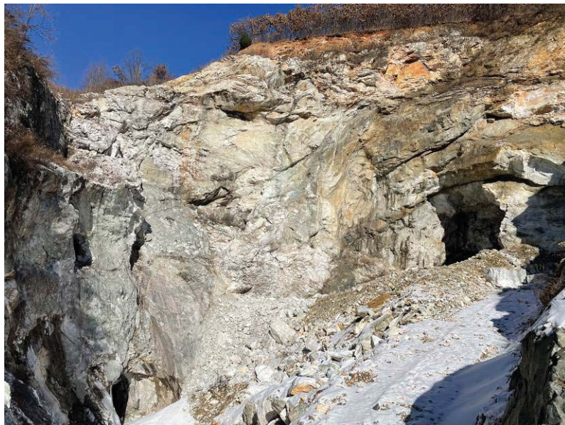
照片 3-1 崩塌地质灾害隐患点
