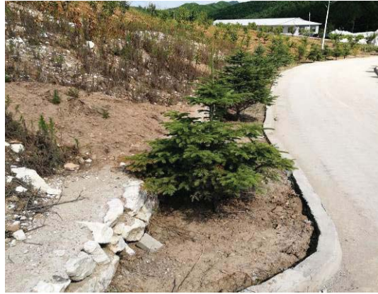
路面平整硬化、栽植景观树
