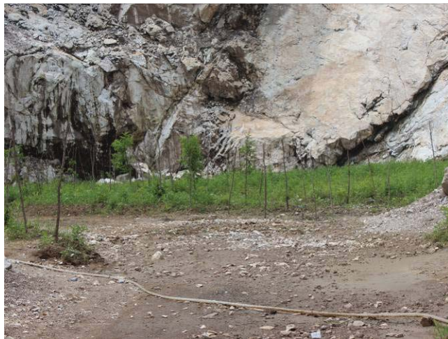
照片 2-7 采场平台治理竣工
