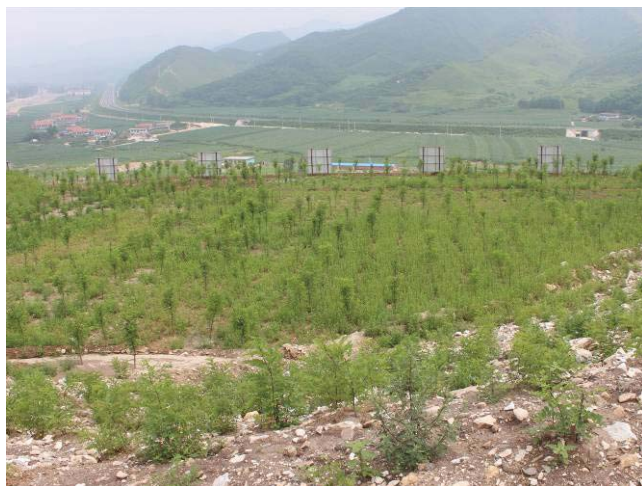
照片 2-5 平台治理竣工
