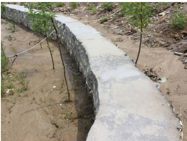
照片 2-8 浆砌石挡土墙
