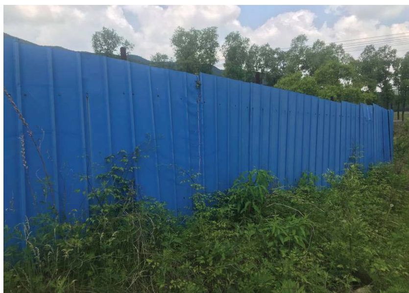
照片 2-5 环绕矿区的彩钢板护栏
