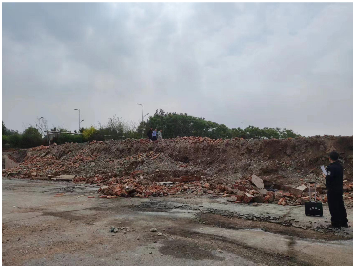
图三：事故现场照片
