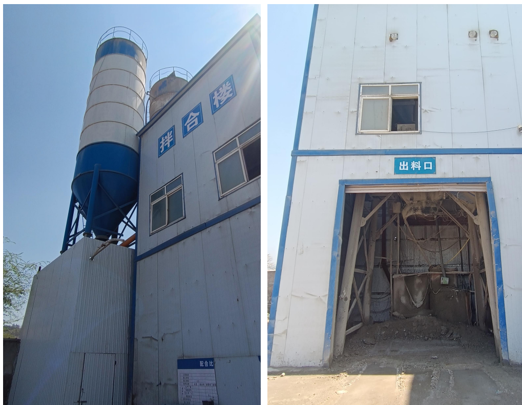
图4 本项目建设情况
