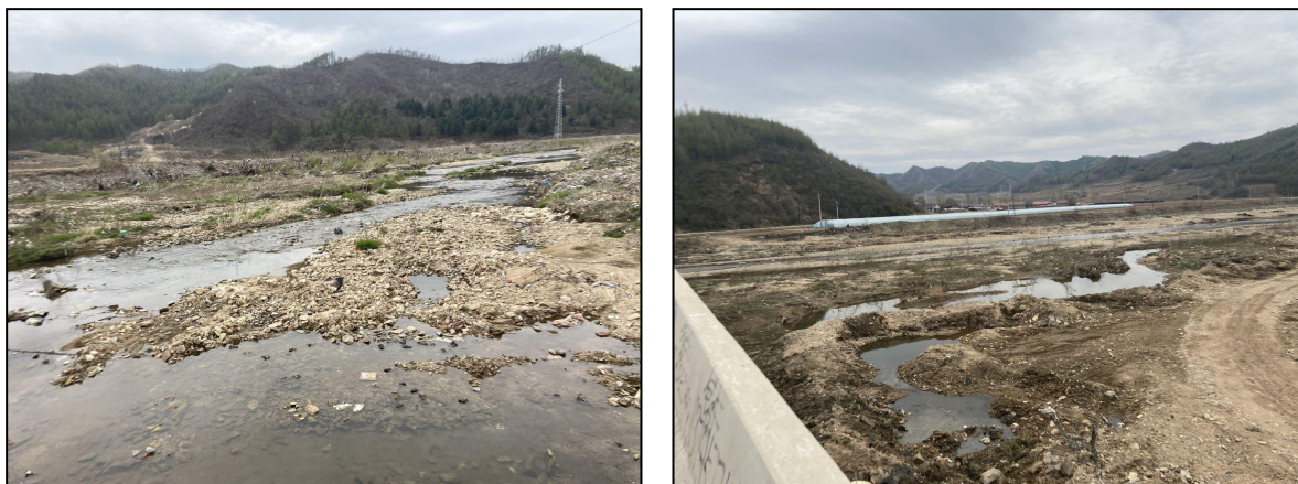
图2.1-1 区域1，（桩号K0+000~K5+068，青河口处—马家堡子处）现状照片
