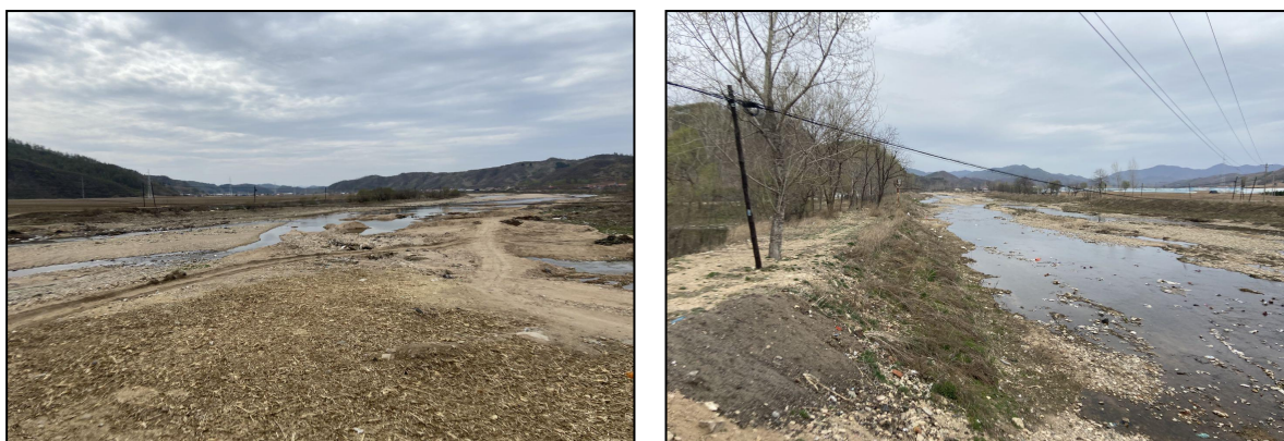
图2.1-3 区域3, (桩号K10+644~K18+469, 老爷庙村处—横道河子处) 现状照片
