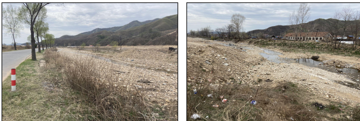
图2.1-4 区域4, (桩号K18+469~K22+320, 横道河子处—马阳沟门处) 现状照片
