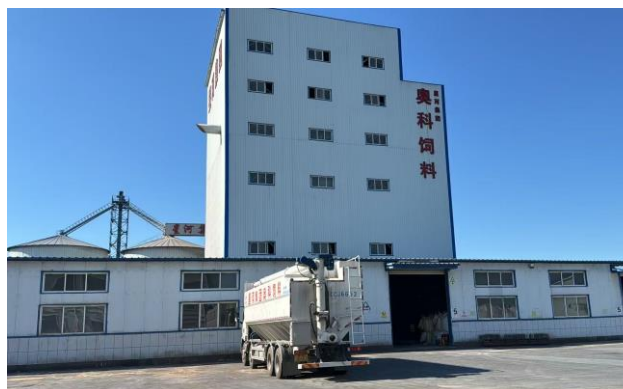
厂区现状照片
