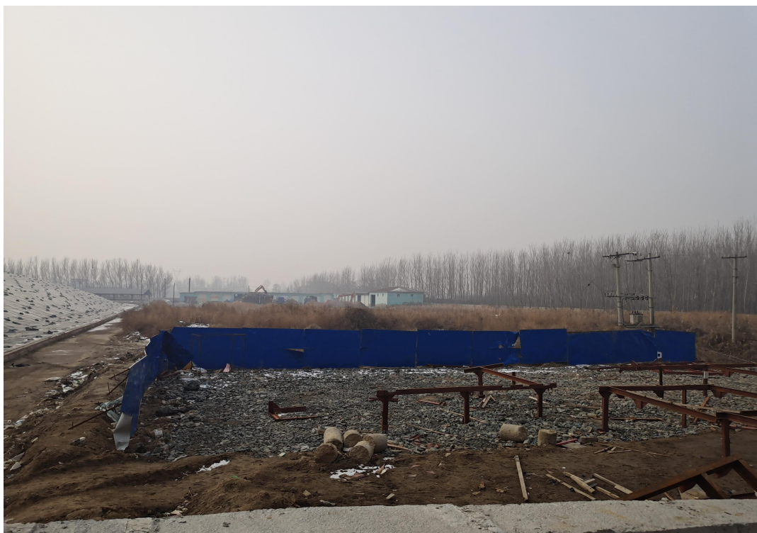
图 3.2-9 本项目场地现状照片
