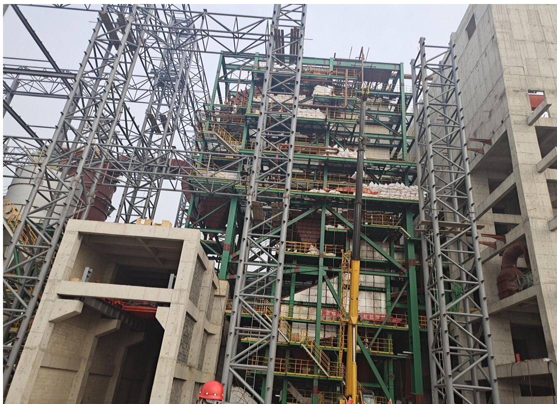
台安县生活垃圾焚烧发电项目（在建项目）建设现场照片
