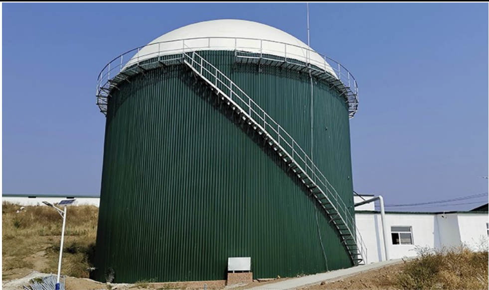
图 4-57 某养猪场 CSTR 工艺工程案例
