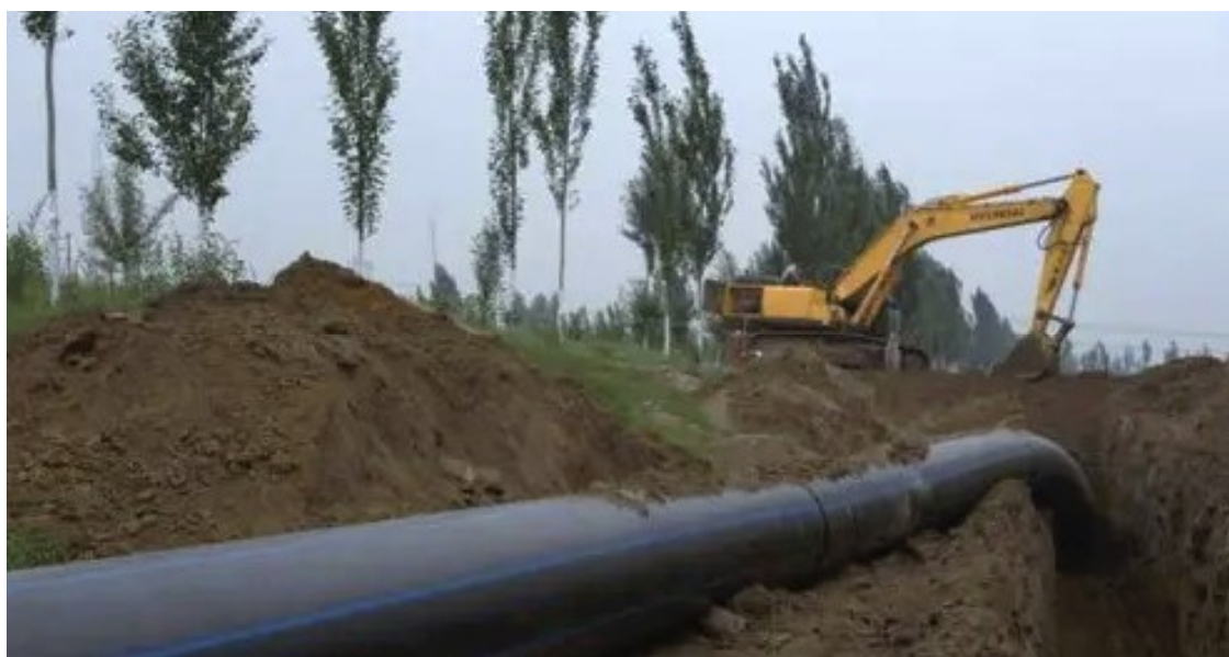
图 4-3 农田灌溉管道施工现场
