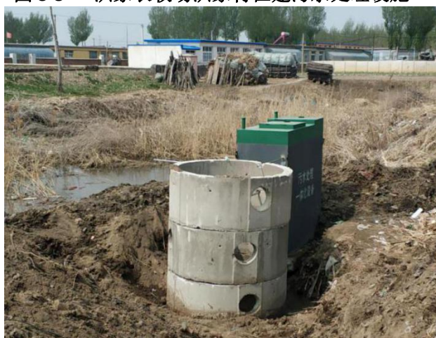
图 3-9 黄沙坨镇刘家村在建污水处理设施
