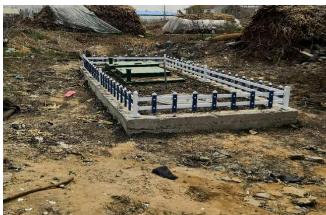
图 3-7 富家镇薄家村在建污水处理设施
