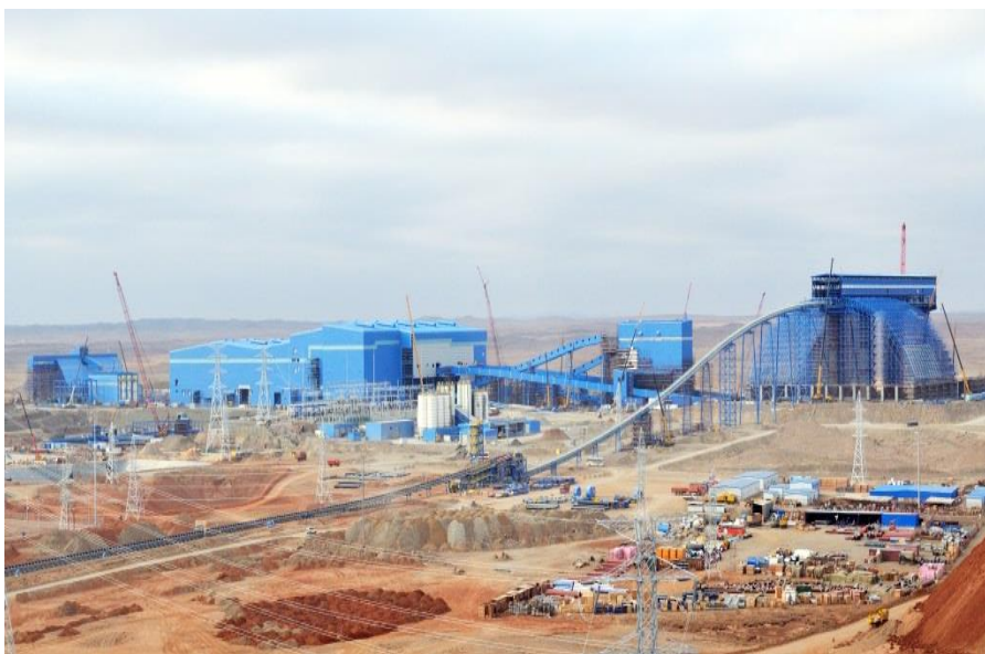
中冶天工集团承建蒙古国奥尤陶勒盖铜矿选矿厂项目
