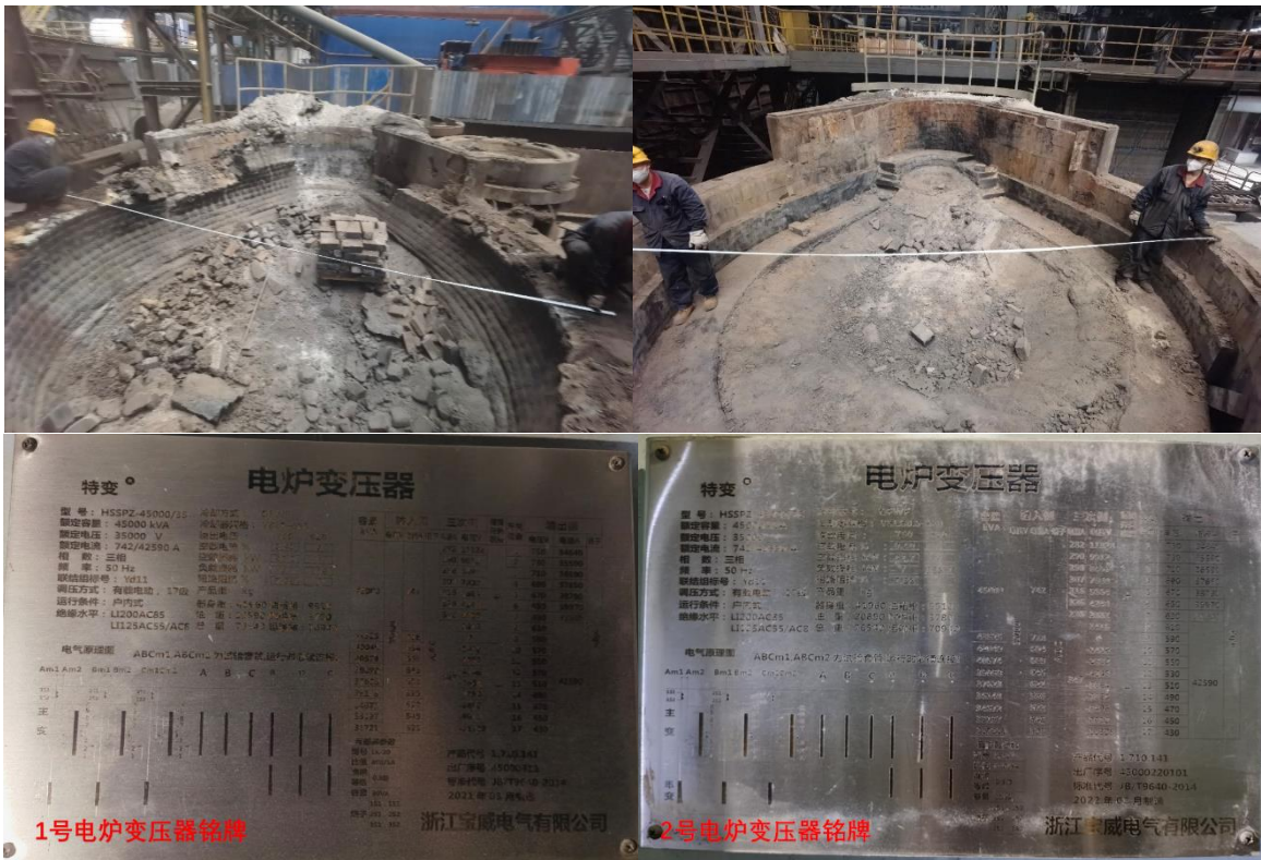
图 3.1-5 电弧炉炉壳直径测量与配套变压器铭牌
