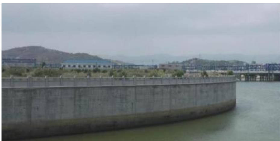
图 2-5 混凝土挡墙防护案例照片
