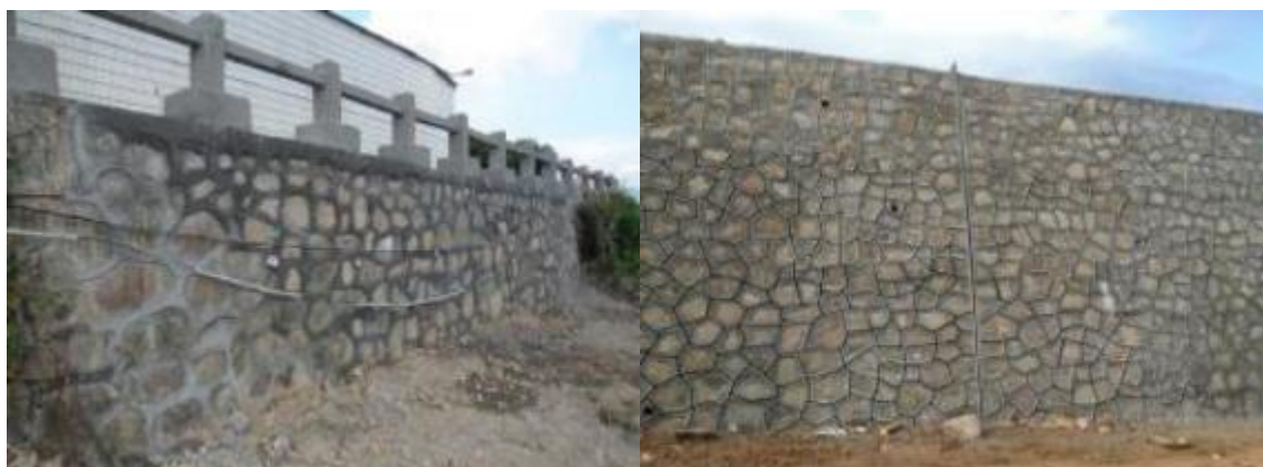
图 2-4 浆砌石挡墙防护案例照片
