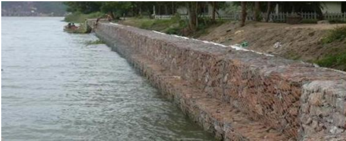
图 2-3 直立式固滨挡墙案例照片
