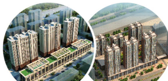
鞍山瑞兆逸家工程 Anshan Ruizhao Yijia Project
