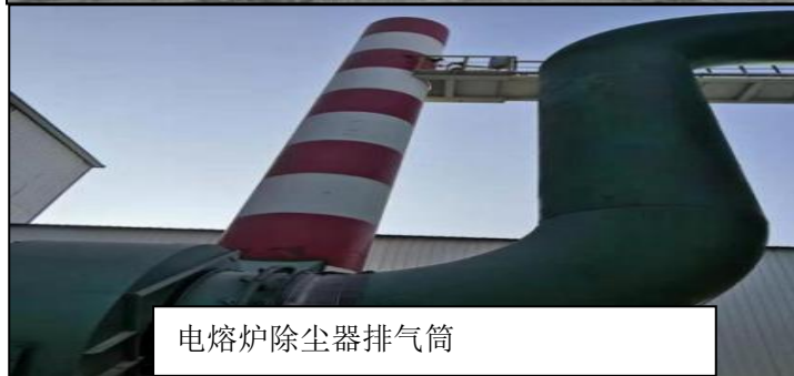
扒炉壳工序 3 号、4 号除尘器及排气筒
