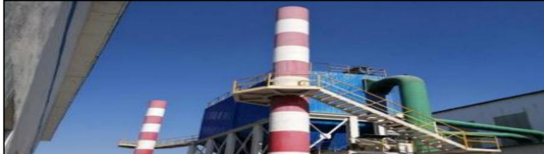
扒炉壳工序 1 号、2 号除尘器及排气筒
