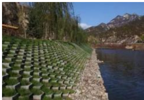
图 14 多孔结构护坡
