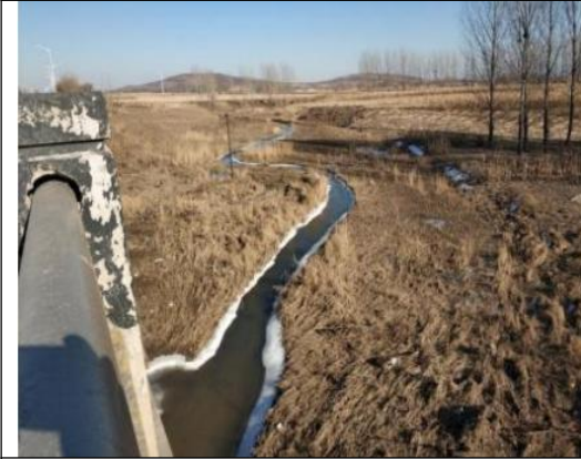
三通河鞍海路桥
