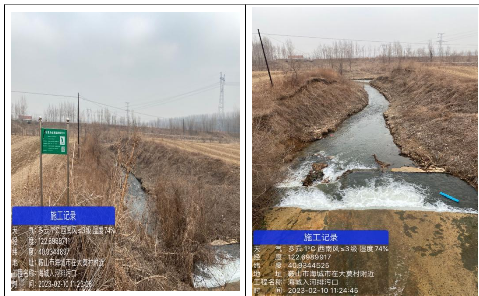
图 5.3-1 排污口现场照片
