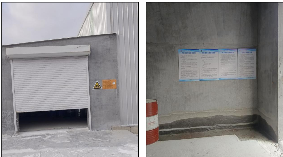
图 5 危险废物暂存间
