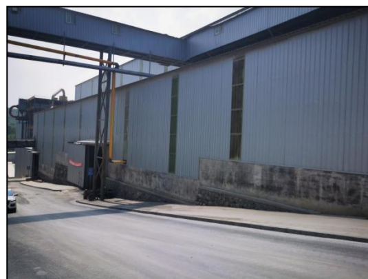
图7 地面硬化及封闭厂房
