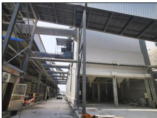
图6 现有项目布袋除尘器照片
