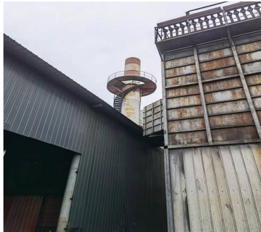
加热炉及其排气筒
