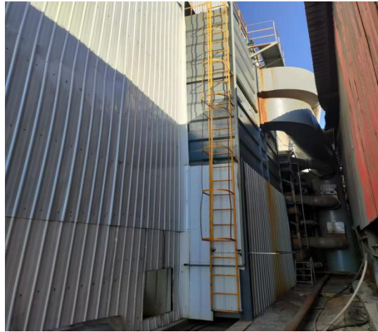
加热炉配套脉冲式布袋除尘器正面及后侧管道
