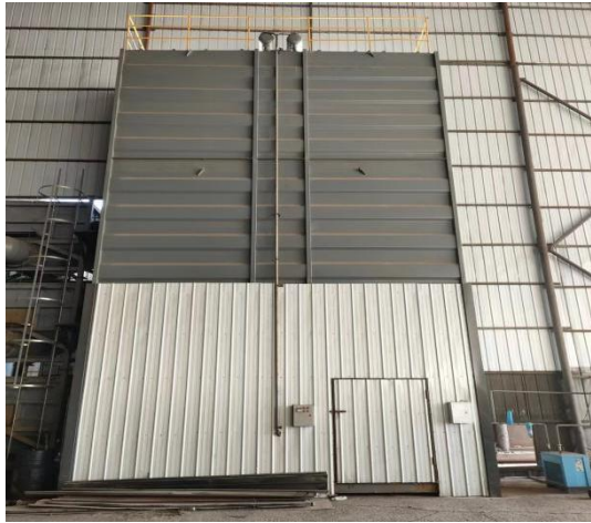
加热炉配套脉冲式布袋除尘器正面及后侧管道
