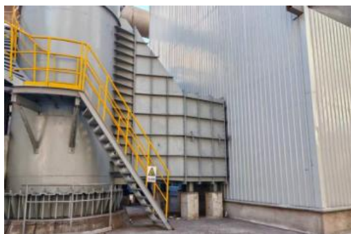
制粒系统风机房加消音器
