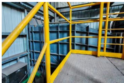
一混系统风机房加消音器
