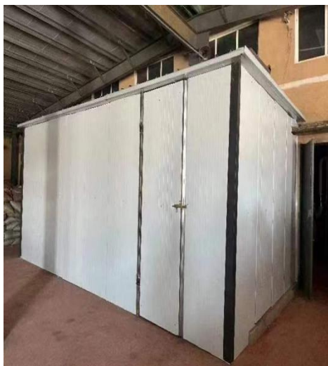
生产车间空压机设备封闭及安装隔音棉
