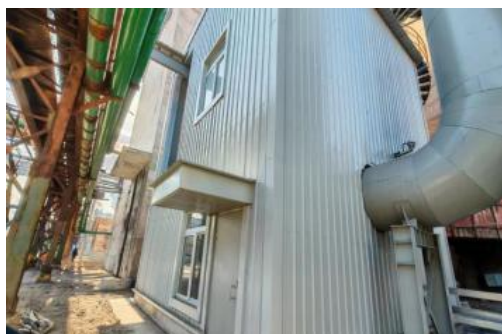
一混系统风机房加消音器
