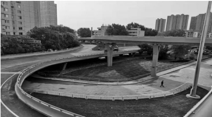
图 16-2 解放路立交桥维修工程
