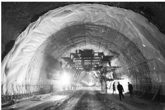
图 19-1 鞍山玉佛山隧道大修
