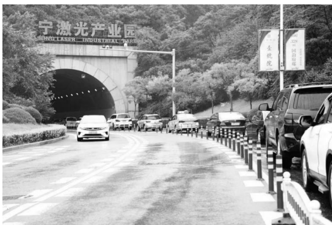
图 19-2 隧道大修期间的单洞双向通行
