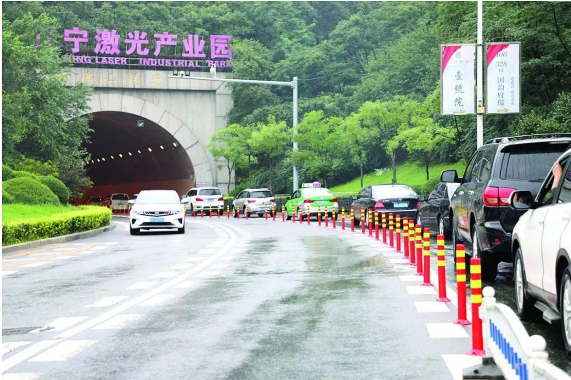
图 19-2 隧道大修期间的单洞双向通行
