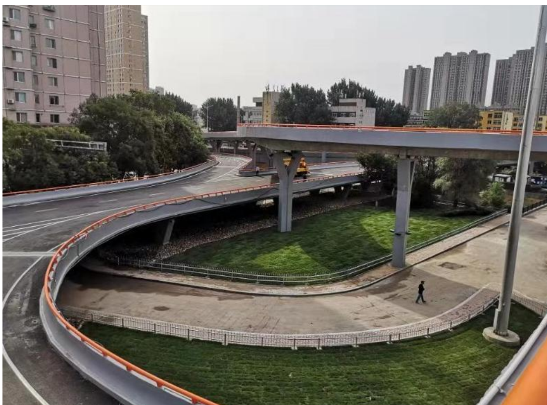
图 16-2 解放路立交桥维修工程
