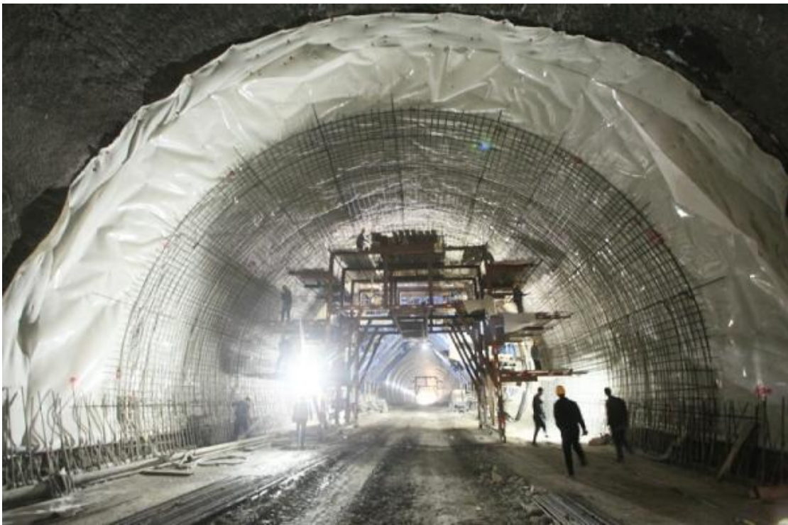
图 19-1 鞍山玉佛山隧道大修
